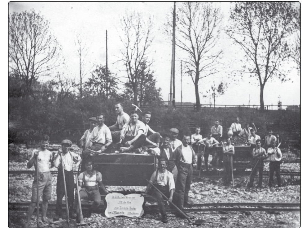
Die letzten beiden Wagen sind gefüllt. Voller Stolz zeigen die Turner ein Schild mit der Aufschrift, dass 362 Kubikmeter Kies und Sand von der Argen zum Bauplatz transportiert wurden.
