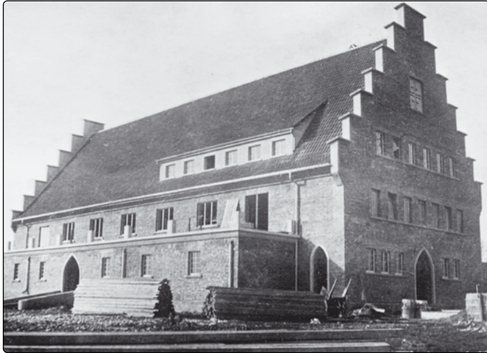
Rohbau der Neuen Turnhalle im Herbst 1926
