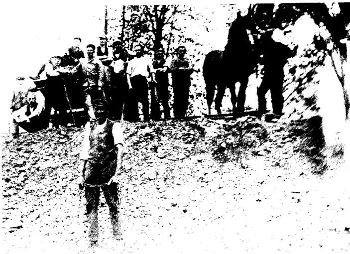
am Bau beteiligten, nirgends verzeichnet. In dieser Fron wurden rund 600 Kubikmeter Kies und Sand aus der Argen mit Hilfe von Gleisen und Loren zum Betonieren herangeschafft!
