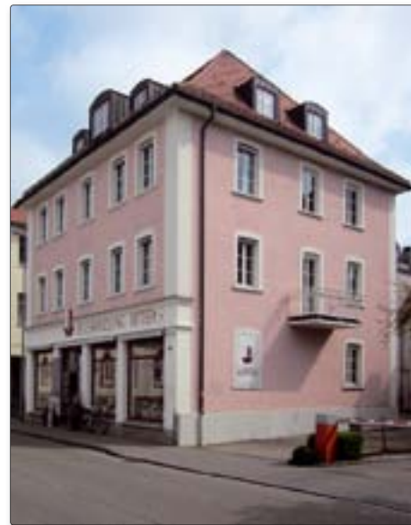
Im ersten Obergeschoss über der Buchhandlung Ritter in der Gegenbaurstraße 10 befand sich die erste MTG-Geschäftsstelle
