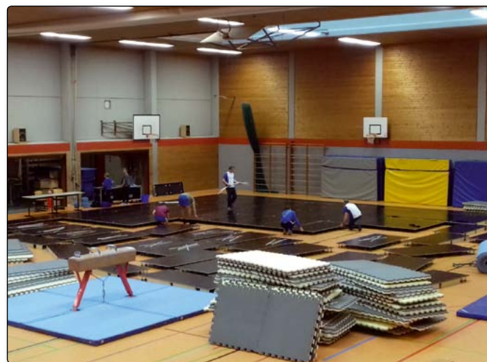
In der Ecke der Halle, wo die Bodenfläche aufgebaut wird, sieht es lange Zeit aus wie auf einer Baustelle.
