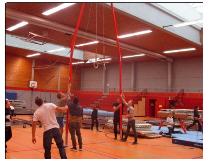
Geschafft! Das Ringe-Gerüst steht und wird seitlich verankert.
