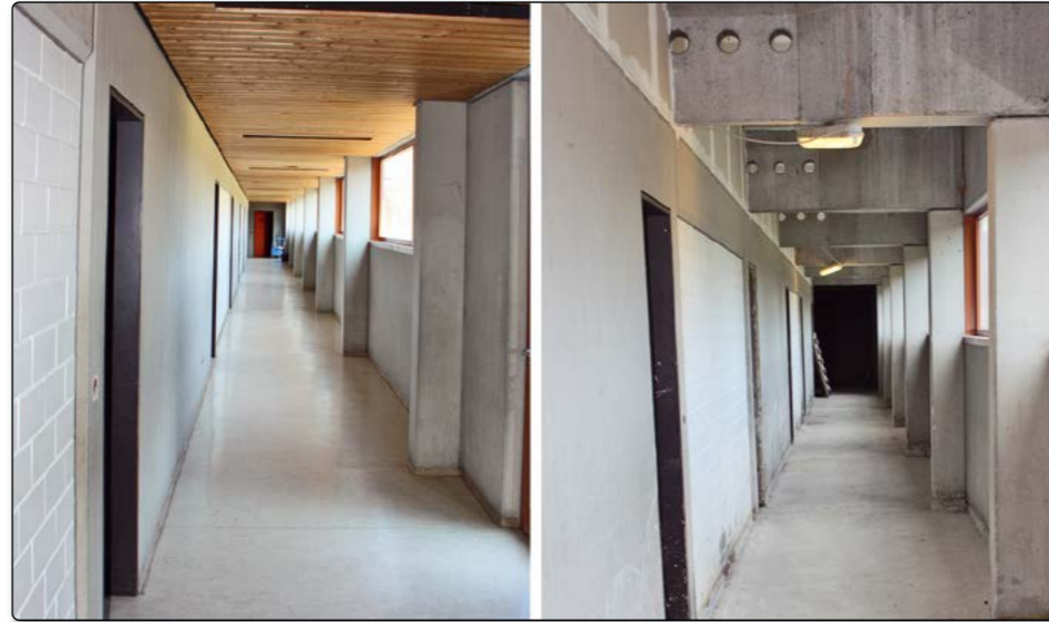
Blick in den Gang vor und während der Sanierung
