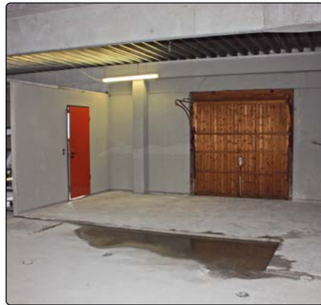
Sanierung der Außengarage
